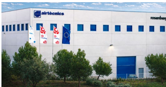
Seu d'Airtècnics a Castellar del Vallès (Barcelona)
